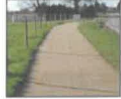
Sablé stabilisé renforcé
