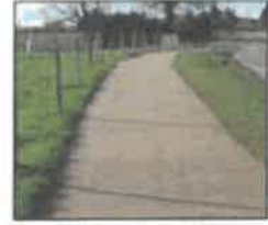
Sable stabilisé renforcé
