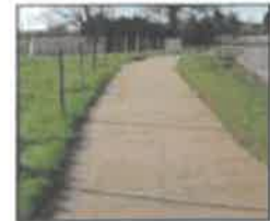
Sable stabilisé renforcé
