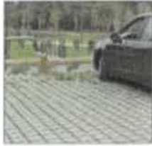
Pavé bétons avec joints engazonnés
