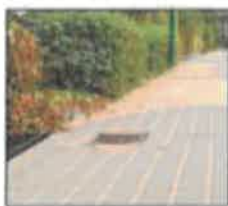
Pavé bétons avec joints sablés
