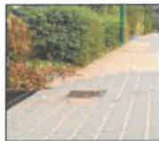
Pavé bétons avec joints sablés
