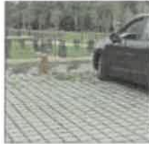
Pavé béton avec joints engazonnés
