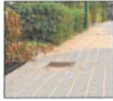
Pavé bétons avec joints sablés
