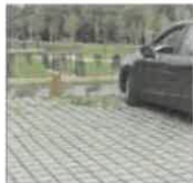
Pavé bétons avec joints engazonnés
